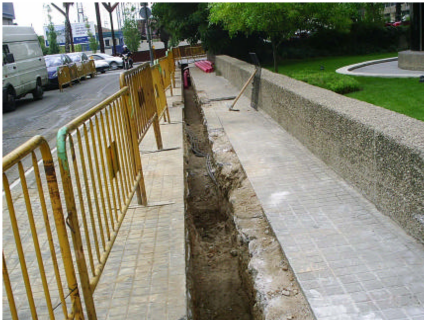
3. Detall en planta de la rasa amb presència de serveis antics
