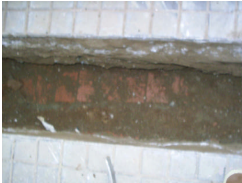
3. Detall en planta de la rasa amb presència de serveis antics
