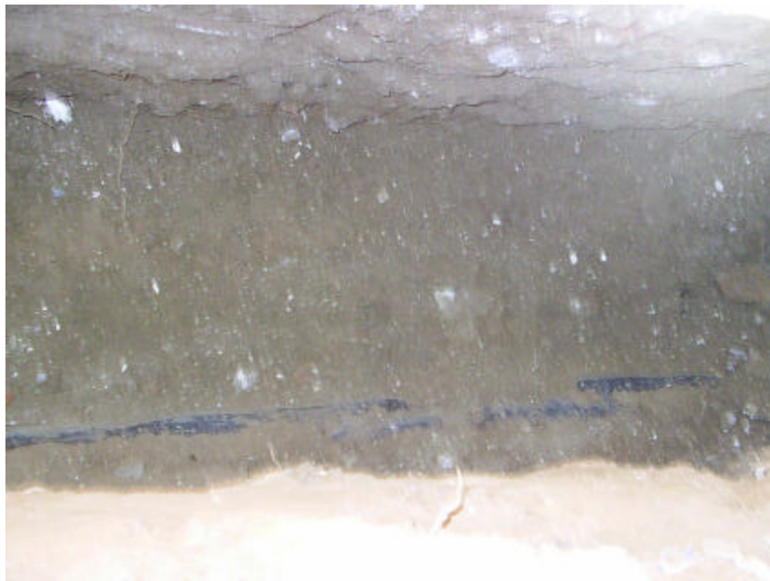
2. Detall d'una secció de la rasa amb presència de serveis antics
