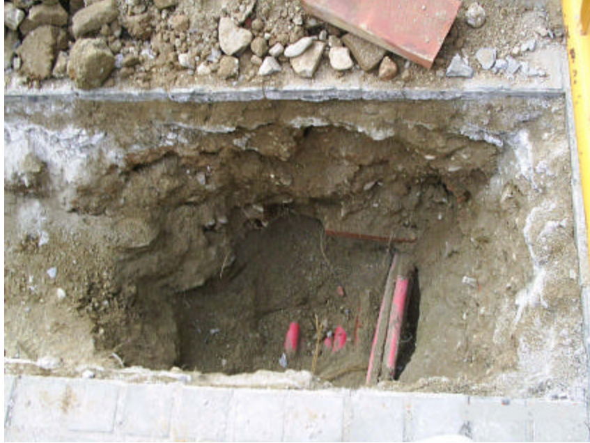
1. Detall d'una cala prèvia a la realització de la rasa amb presència de serveis antics
